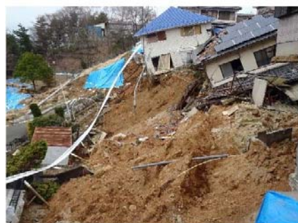
地震による造成地盛土崩壊
