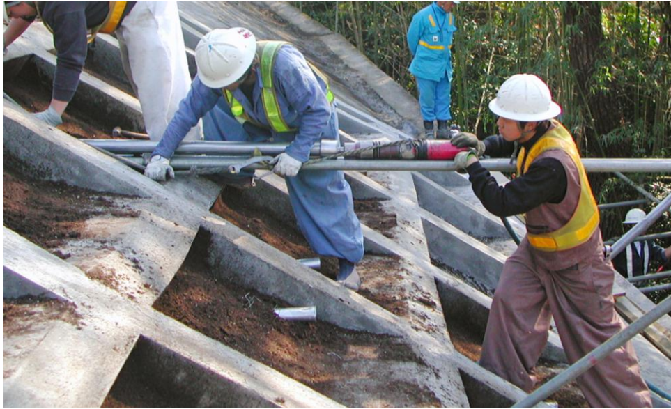
写真－1 排水補強パイプ打込み状況
