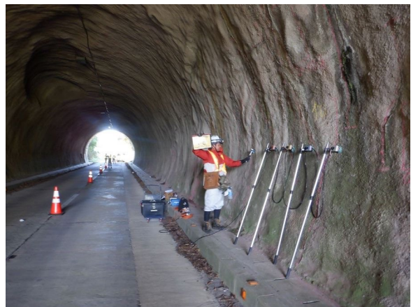
写真-1 トンネルでの表面波探査状況
