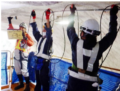
写真-2 トンネル天井部の表面波探査状況
