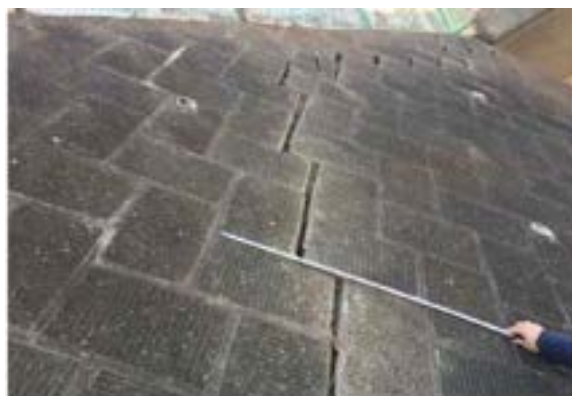
図 3.4.25 宅地擁壁の損傷例
