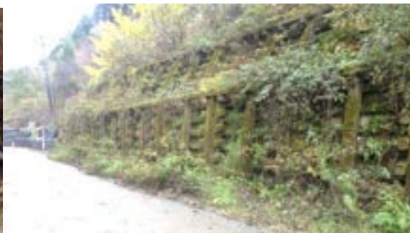
左図 5.2.3-48 地震後 3 月の C 変形した枠組み擁壁（斜面の押し出しにより変形，上部斜面は緩みあり）
