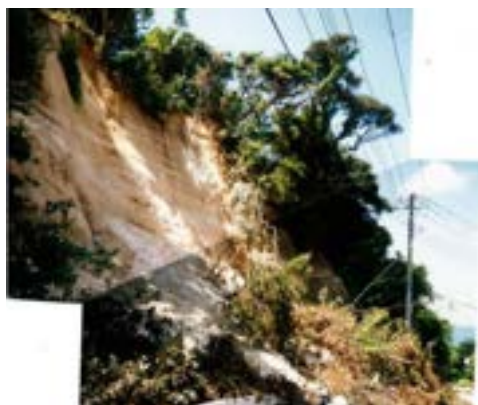
図 3.3.6 地震動に伴うのり枠工の滑落
