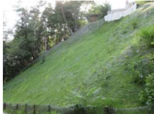
図 3.2.7 柔なのり面工の建設事例
