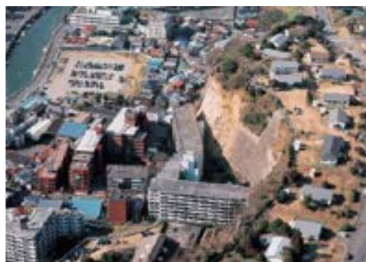
図 3.3.5 老朽化が主原因で吹付法面が大規模に剥落した事例 8)
