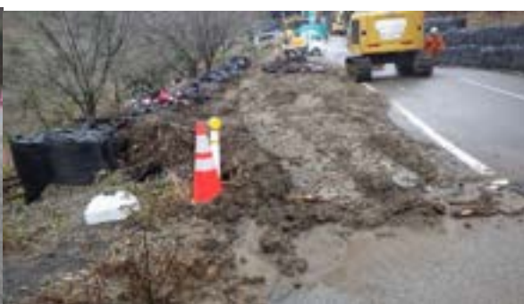
左図 5.2.3-52 地震後 3 月の D 変形斜面下の E 変形盛土（段差・押し出しがあり，地盤が緩んでいる）
