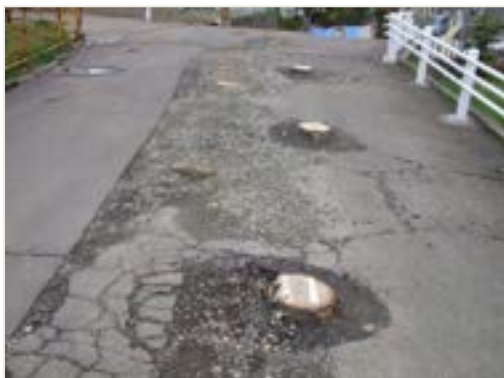
図 3.3.4 想定を超える地震により、既存の地すべり対策工抑止杭が変位している事例 7)
