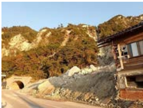
左図 5. 2. 3-12 新トンネル西口付近の豪雨後の道路土砂除去復旧の状況（2024 年 11 月 9 日撮影） 1)
