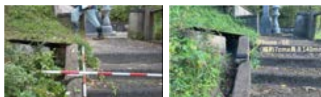
(b) 斜面上の階段亀裂の拡大状況
