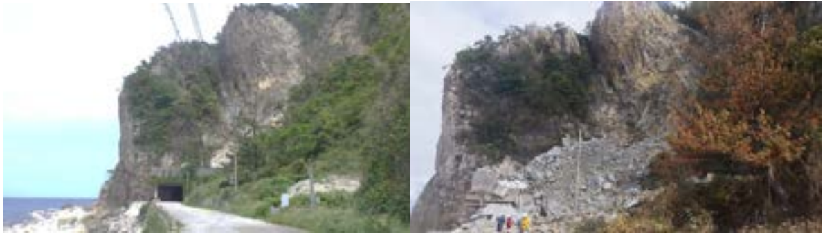
左図 5. 2. 3-14 八世乃洞門の 1 月地震後の斜面の緩み、洞門に被害無 (2024 年 5 月 26 日撮影)
