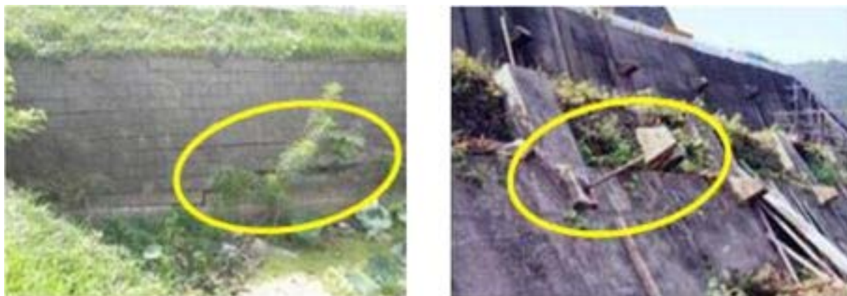
図4.2.22 防災施設における変状事例（左：ブロック積み擁壁、右：グラウンドアンカー工） 2)
