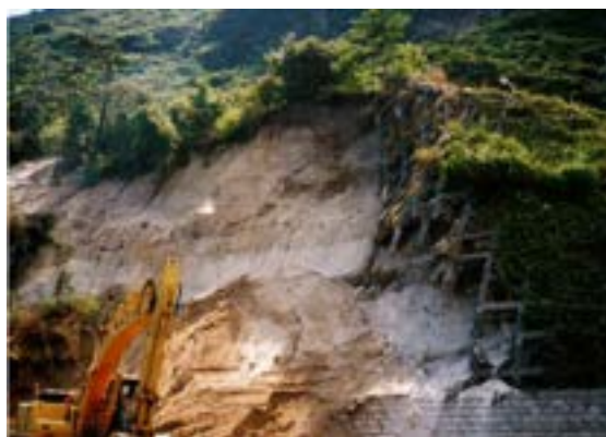
図 3.3.6 地震動に伴うのり枠工の滑落
