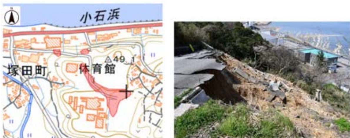
図 3.1.16 輪島市総合体育館・野球場の盛土地盤の滑動及び斜面崩壊の様子 5)
