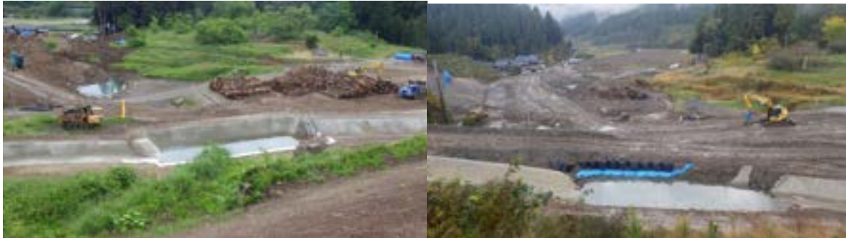
左図 5. 2. 3-30 市ノ瀬地すべり堰止湖からの復旧仮排水路の大型貯水マス (2024 年 5 月 27 日撮影)
