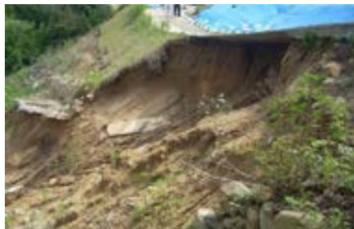
図 3. 1. 4 小段に排水施設がない場合の変状・崩壊の事例
