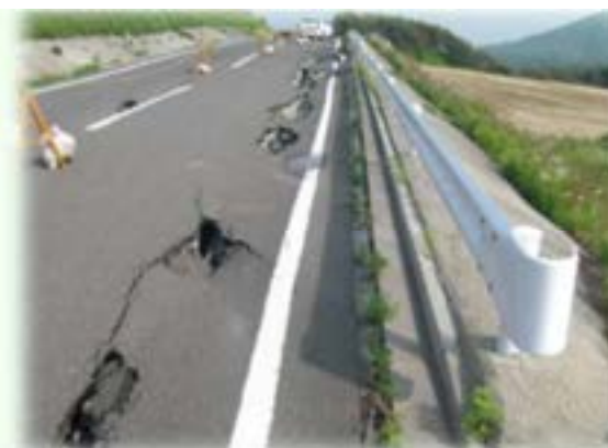
補強対策を行わなかった箇所では、押出し（左）や沈下・陥没（右）の変状発生
