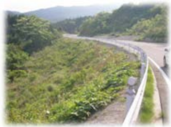
地震発生後 (路面のひび割れや沈下は認められない)
