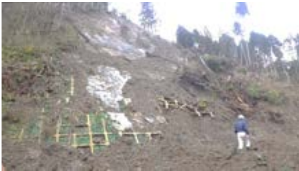
左図 5.2-3.58 豪雨後 11 月の J 崩壊で I 崩壊の側方への拡大
