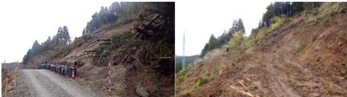
左図 5. 2. 3-44 地震後3月のB崩壊土砂（崩壊土砂は除去すると危険なので，残したまま仮復旧している）
