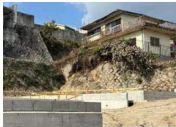
(b) 隣接擁壁が崩壊している
