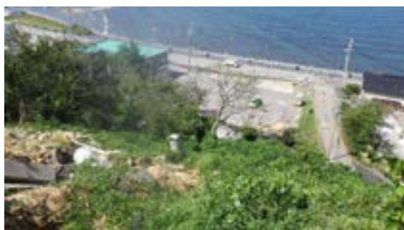
図 5.2.3-23 地震後 5 月の野球場北側末端崖の小崩壊状況, 9 月豪雨で大きく崩落した
