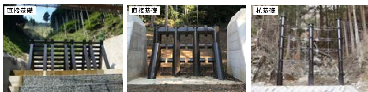
図 3.2.17 無流水溪流における土石流捕捉工の建設事例
