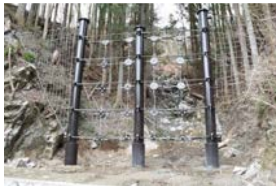
図 3.2.16 透過型施設側方からの土砂流出防止対策（金網付）の例 7)
