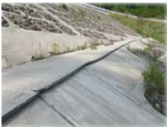
補強対策を行わなかった箇所では、押出し（左）や沈下・陥没（右）の変状発生
