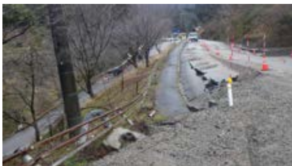
左図 5.2.3-52 地震後 3 月の D 変形斜面下の E 変形盛土（段差・押し出しがあり，地盤が緩んでいる）
