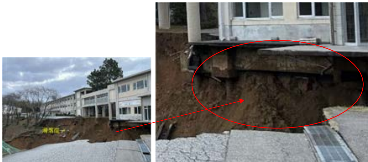
図 3.1.23 杭基礎で崩落を免れた校舎の状況（写真は塚脇真二 1) ）
