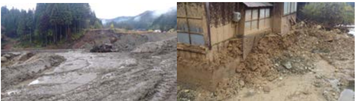
左図 5. 2. 3-32 9 月豪雨で大型貯水マスから越流して下流に土砂流出 (2024 年 11 月 24 日撮影)
