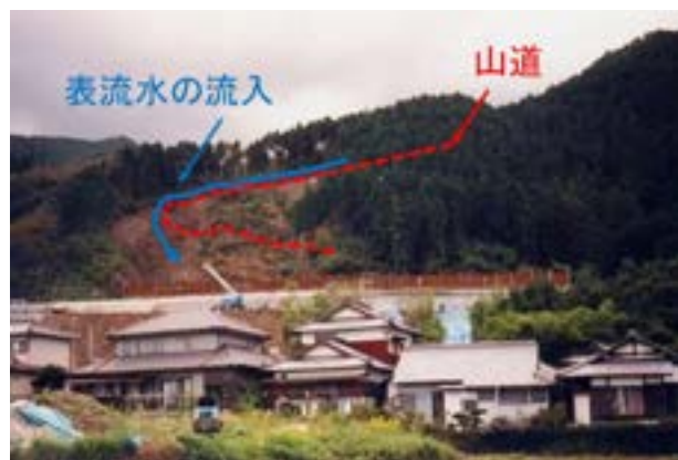
図 5.1.8 崩壊地と表流水の流下した山道
