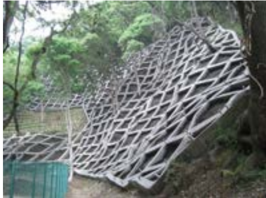
図 3.2.6 のり枠工の建設事例
