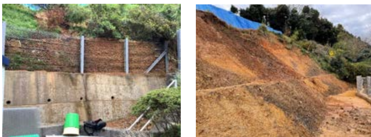
図 3.2.3 崩壊土砂の堆積状況（左）と法面整形後の小崩壊（右）
