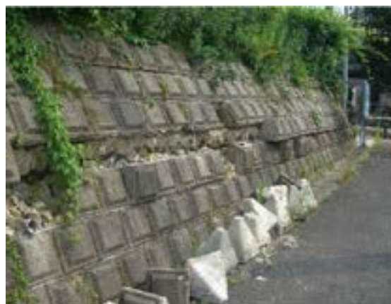
図 3.4.15 地震による宅地擁壁の被災例 2)
