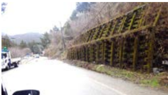
左図 5.2.3-48 地震後 3 月の C 変形した枠組み擁壁（斜面の押し出しにより変形，上部斜面は緩みあり）
