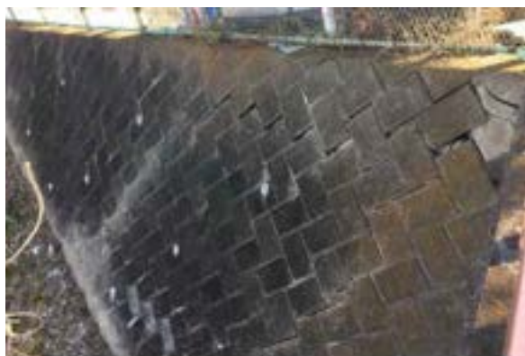
図 3.4.24 宅地擁壁の損傷例
