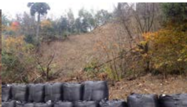
左図 5.2.3-50 地震後 3 月の D 変形した地すべり対策工斜面（植生は残っている）
