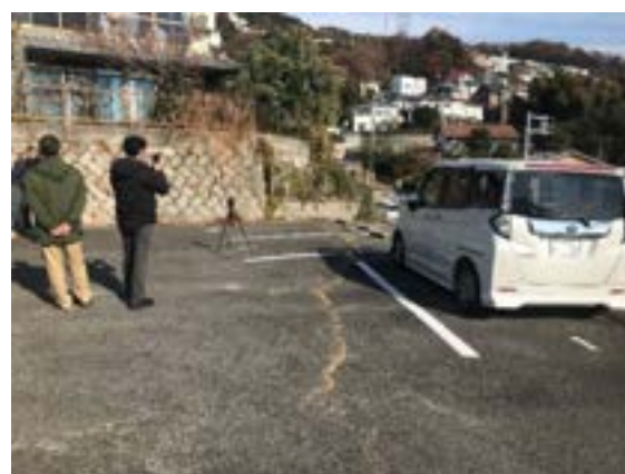
図 3. 4. 14 擁壁天端のアスファルト舗装のクラック
