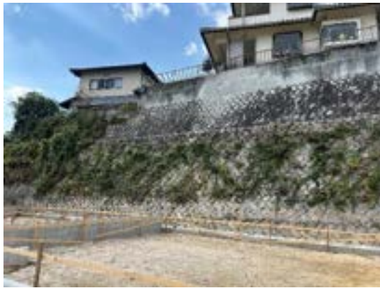
(a) 下部擁壁に植栽が繁茂している
