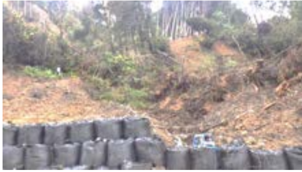
左図 5.2.3-56 豪雨後 11 月の H 溪岸崩壊による谷内での土砂の堰き止め
