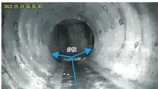
写真-4 暗渠管吐口から約60m進んだ地点の映像
