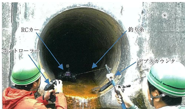
写真-3 点検の様子
