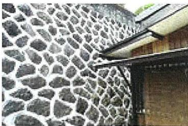
図-9 擁壁と家屋が近接する現場で石積接着補強工法を施工した状況
