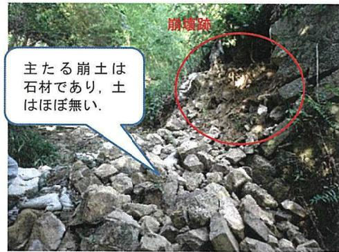
図-1 空石積擁壁の崩壊事例
