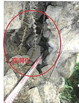
図-2 空石積擁壁背後の空洞化
