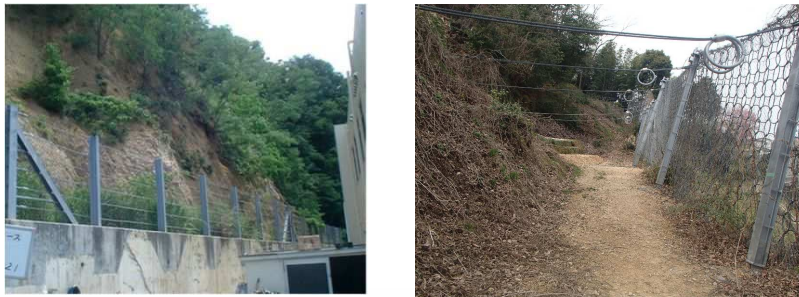
待ち受け型の落石対策工
