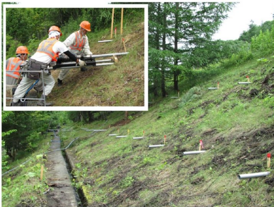
図 10 北海道での施工事例（道路法面）
