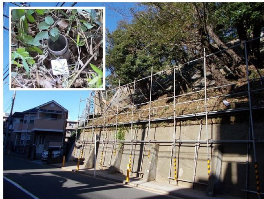
図 11 横浜市での施工事例（YZ 民間斜面）
