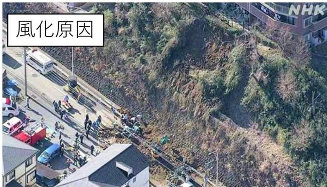
風化により不安定になっている斜面は、**土塊の除去**か抑止工での対策となる。
