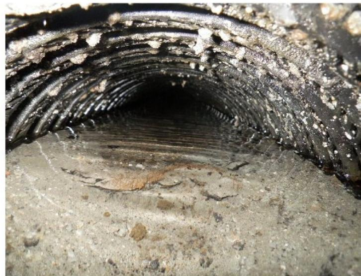
写真 6 中央排水工法で施工された盛土竣工直後の暗渠管の内部写真
