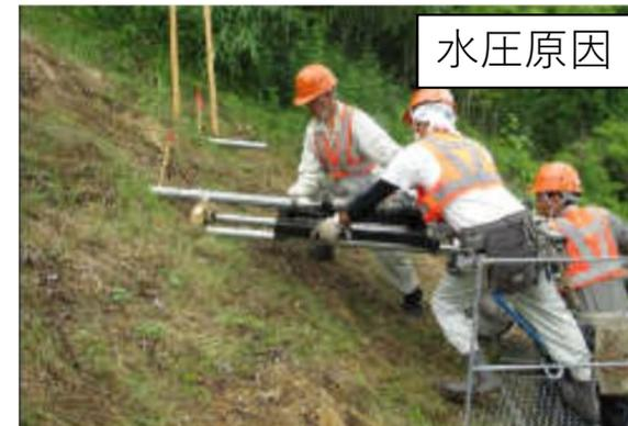
高水圧が発生したときにのみ不安定になる斜面は、**過剰間隙水圧消散で安定化**できる。
