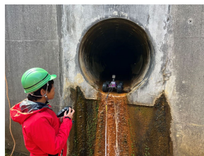
図-4 実験場の暗渠管
