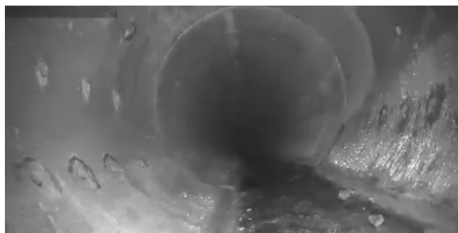
図-5 暗渠吐口から約 50m 進んだ地点の映像
