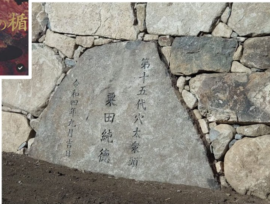
穴太衆積み（野面積み）の石垣は「空積み」
