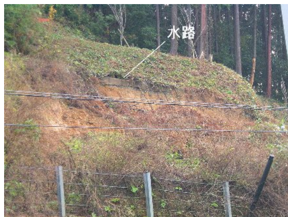
水路が閉塞し、溢水して崩壊
