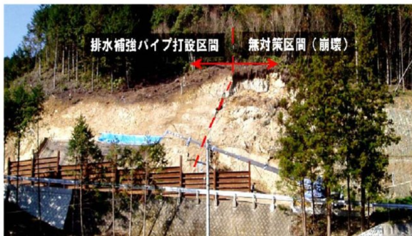
三波川帯の強風化岩の切土法面に施工された排水補強パイプとその効果
