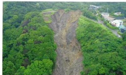
資料1 ■ 2021年7月3日に静岡県熱海市で発生した土石流。この土石流災害をきっかけに危険な盛り土の規制が本格的に動き出した(写真:静岡新聞)
