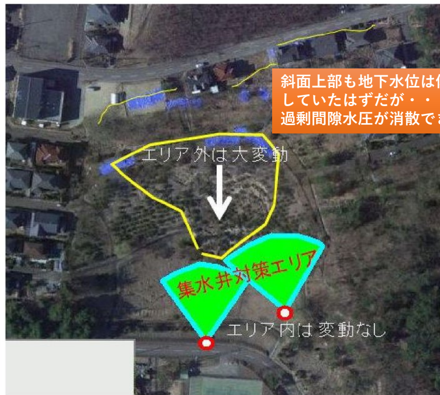
写真5 集水ボーリング到達域は変動せず 対策効果は「排水距離」が支配している
