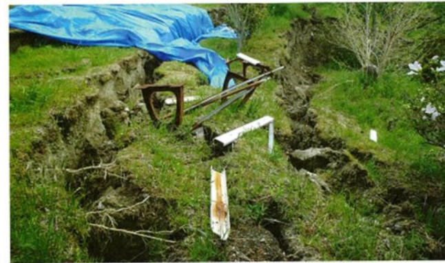
資料3 ■ 2011年の東日本大震災で崩れた宮城県白石市の斜面(写真:太田英将)
