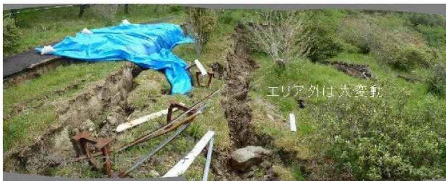
写真4 集水ボーリング到達外の大変動
