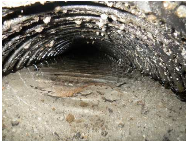
写真 6 中央排水工法で施工された盛土竣工直後の暗渠管の内部写真
