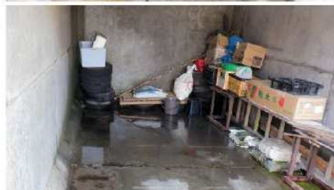
写真3 全てのガレージの奥に水が溜まった (地震から4か月後)
