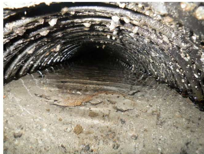
写真 6 中央排水工法で施工された盛土竣工直後の暗渠管の内部写真
