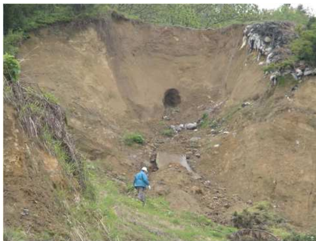
図 4 2004 年新潟県中越地震時の崩壊跡 記録的豪雨時の爆裂孔と同様の爆裂孔があった
