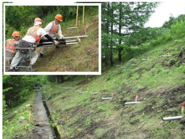
図 10 北海道での施工事例（道路法面）
