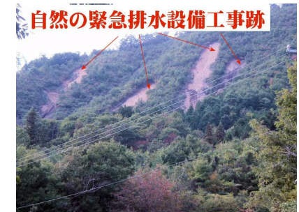
見かけは崩壊だが、実は自然の地下水排除工の工事跡では？
