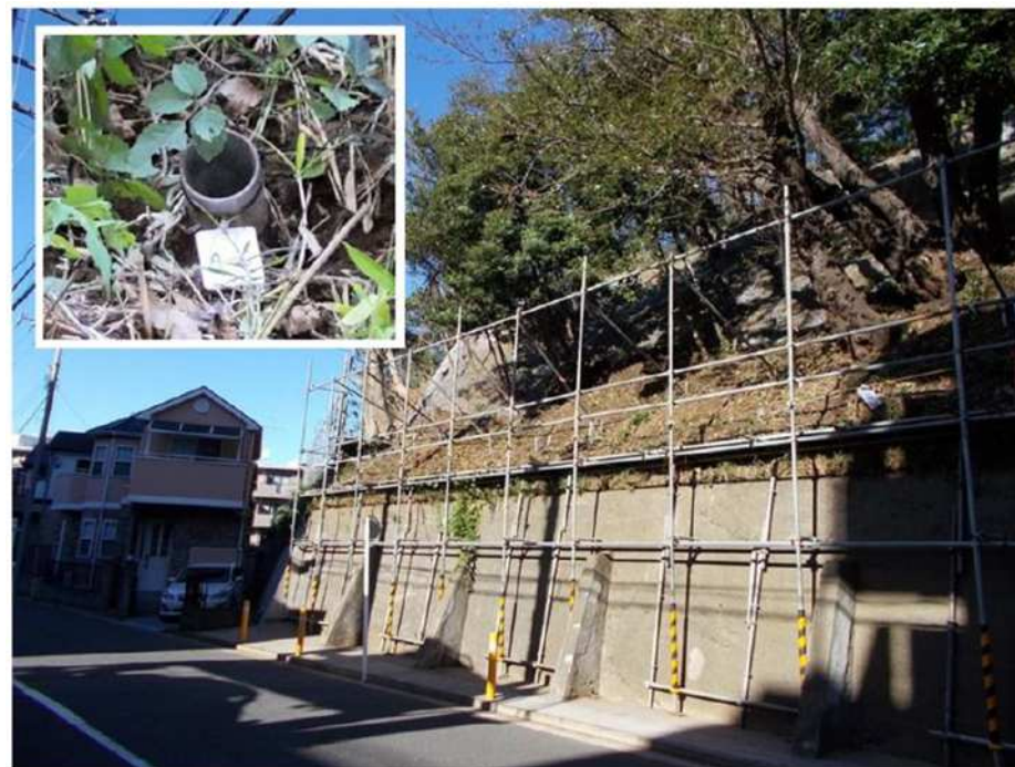
図 11 横浜市での施工事例（YZ 民間斜面）
