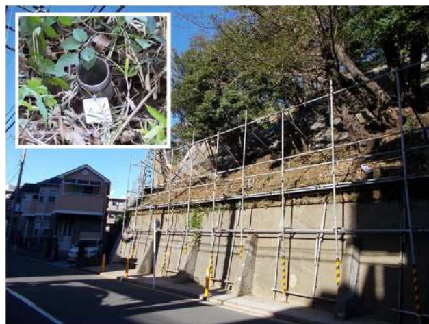
図 11 横浜市での施工事例（YZ 民間斜面）
