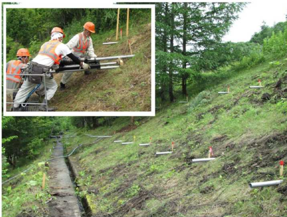
図 10 北海道での施工事例（道路法面）
