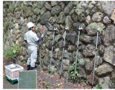
擁壁の表面波探査
