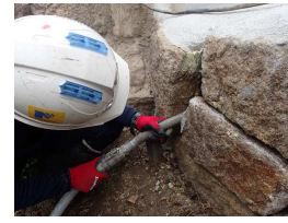
接着性充填剤の注入状況
