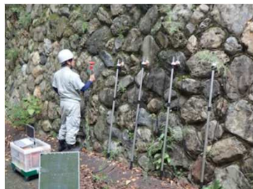
擁壁の表面波探査状況
