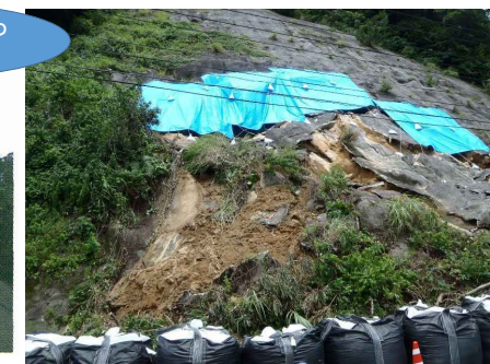
モルタル吹付斜面の崩壊
