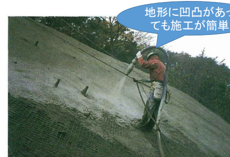
モルタル吹付施工状況 (高速道路技術センター:現場のチェックポイント,平成11年3月より引用)
