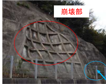
現在のモルタル吹付斜面の状況
