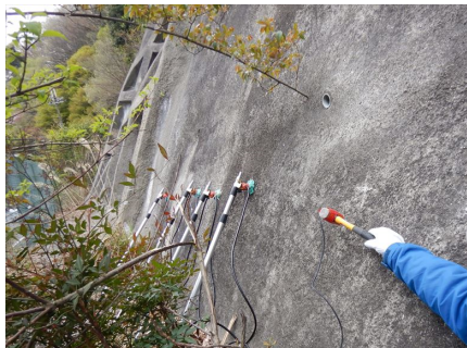
図-2 一次元表面波探査状況
