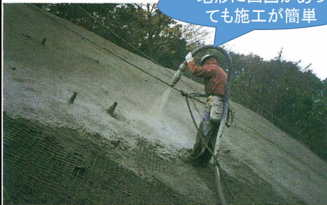
モルタル吹付施工状況 (高速道路技術センター:現場のチェックポイント,平成11年3月より引用)
