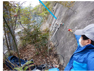
一次元表面波探査実施状況
