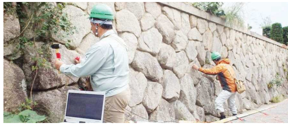
図-11 擁壁の表面波探査状況
