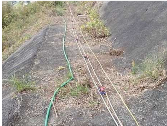
図-7 モルタル吹付斜面の表面波探査状況
