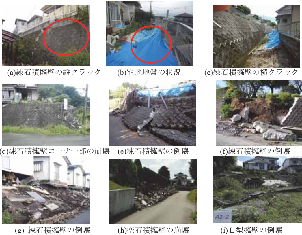
写真 8.2-1 宅地擁壁の被害状況
