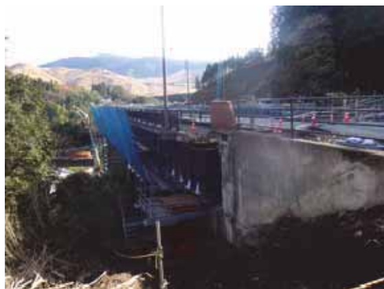
補修工事中の大切畑大橋
