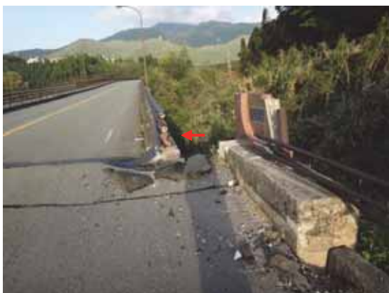
上部工が横に移動した大切畑大橋（災害直後）
