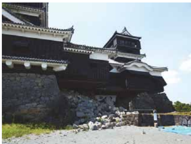
写真 8.1-21 大天守と小天守の間の石垣の被害
