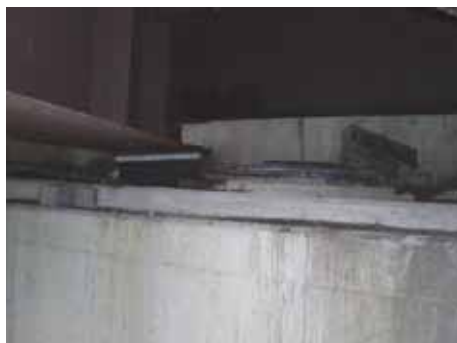
写真 5.2-5 A2 橋台の支承
