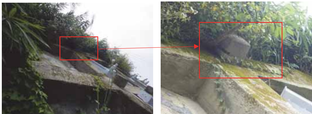
写真 4.3-11 アンカー頭部コンクリート破損状況
