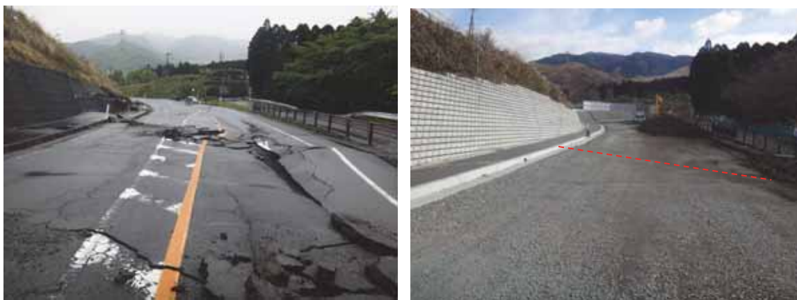
災害直後の状況（右横ずれ）
