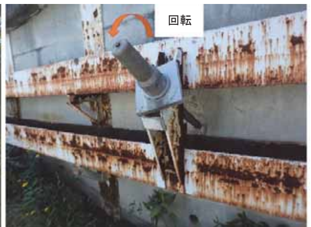
写真4.2-3 アンカーの変状状況（破断と回転）
