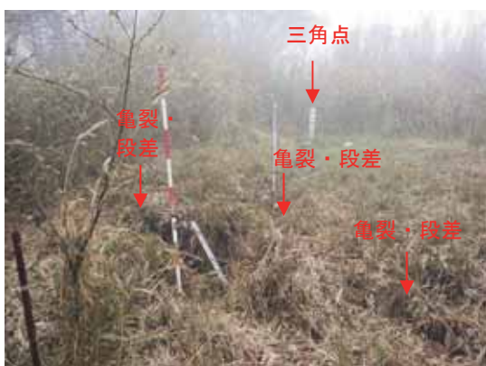
図 2.8-11 亀裂と三角点
