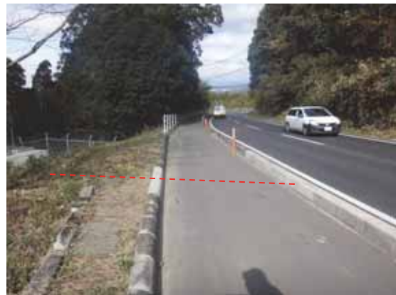
復旧工事後の状況
