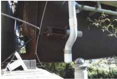
写真 5.2-9 A1 橋台の落橋防止ケーブルの破断
