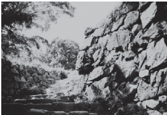
写真 8.1-4 穴太工法例 (安土城) 8)
