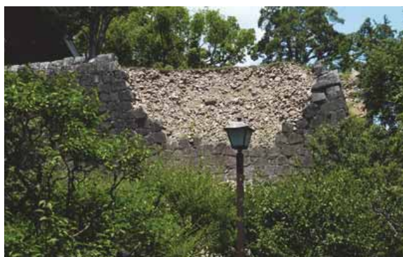
写真 8.1-19 数奇屋丸二階御広間東側の石垣崩落
