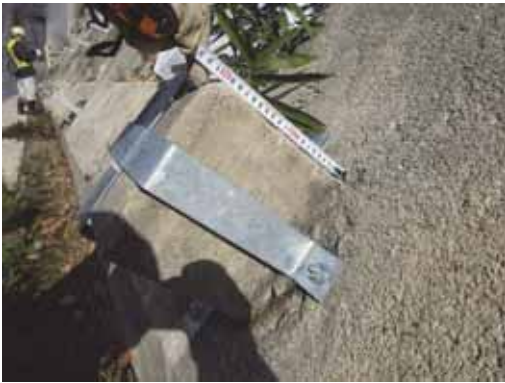
写真 4.3-2 アンカーの頭部コンクリートは、 200 \times 200 \times 200 でアンカー破断時の飛び出し防止を目的に十字に帯鋼板が設置されている。
