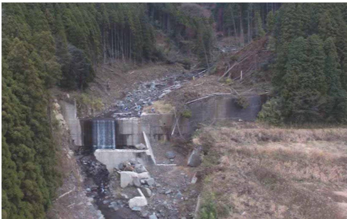
写真 2.5-6 谷出口（三王谷川砂防堰堤）堆砂状況（2017/12/10 撮影）
