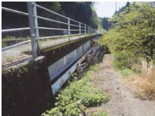
写真 4.3-13 アンカー付き山留め杭擁壁
