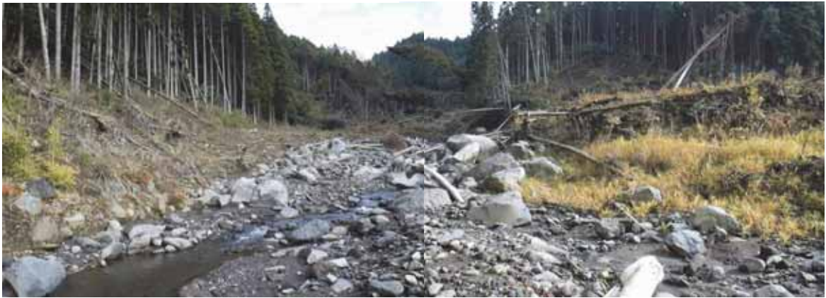
写真 2.5-8 三王谷川砂防堰堤上流の土砂堆積状況 (2017/12/10 撮影)
