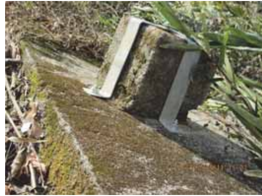
写真 4.3-3 頭部コンクリートが亀甲状に割れて欠損しており、コンクリート自体の劣化が進行している。
