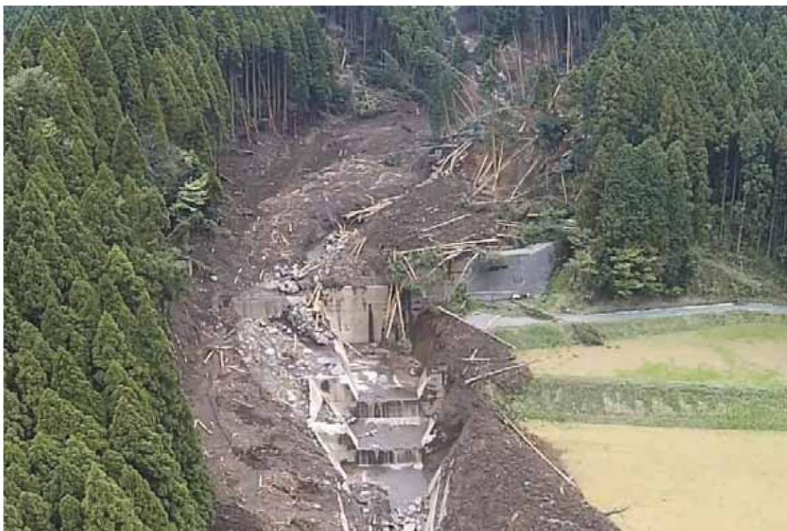
写真 2.5-4 谷出口（三王谷川砂防堰堤）堆砂状況（2016/4/26 撮影）
