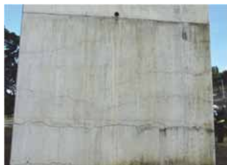
写真 5.2-8 P2 橋脚山側の曲げひび割れ
