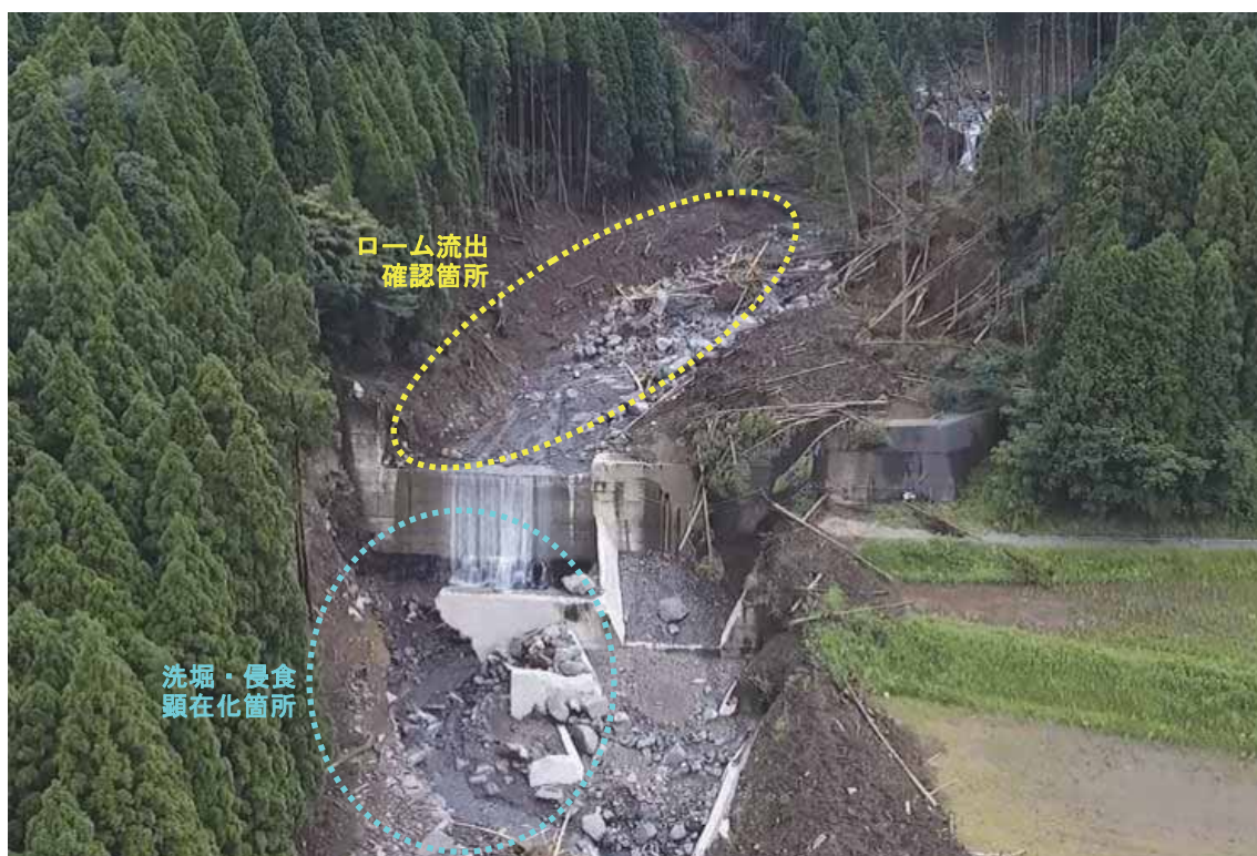
写真 2.5-5 谷出口（三王谷川砂防堰堤）堆砂状況（2016/7/1 撮影）
