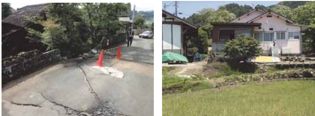
図 1.1-3 2016年熊本地震本震による地表地震断層による被害（いずれも益城町下陳）
