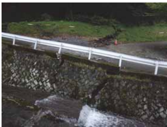
災害直後の状況（流路工被災）
