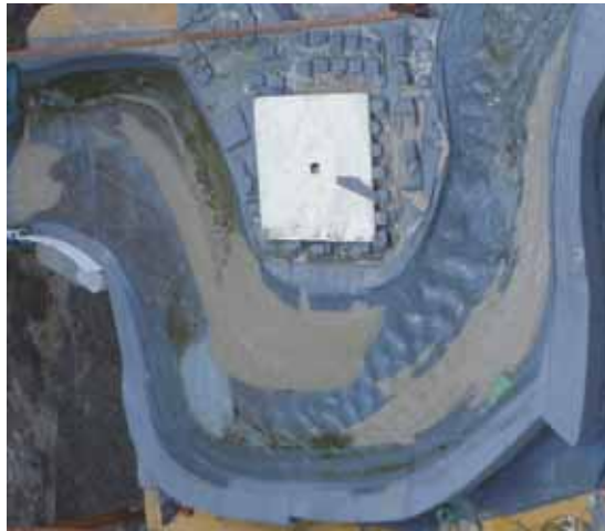
写真 7.3-4 土砂の堆積状況 (CaseMS-1)
