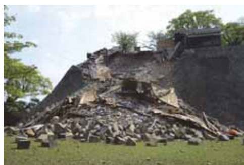
写真 8.1-2 重要文化財「北十八間櫓」の崩壊
