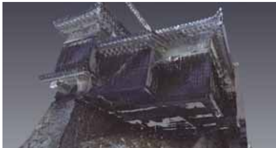
(c) 石垣崩壊部
