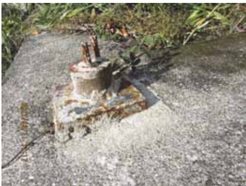
写真 4.3-4 既設アンカーは、2 本より線でクサビ方式で定着されている。
