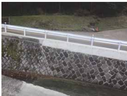
復旧工事の状況
