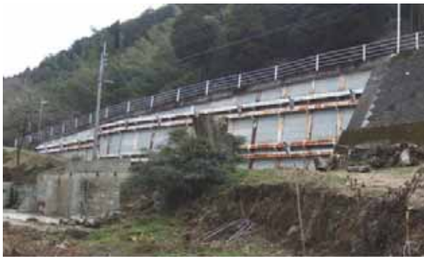
写真4.2-2 アンカー付き山留め式擁壁全景
