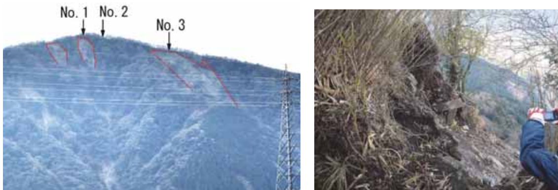
図 2.8-2 左写真は調査対象地の全景（No.1～No.3 は後述の調査地点）、右写真は調査地点 No.1 の斜面崩壊（滑落崖）の状況
