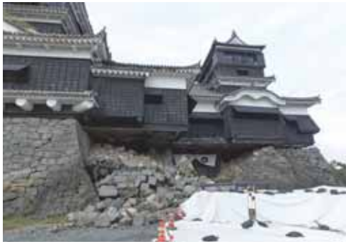
(a) 東側の石垣崩壊
