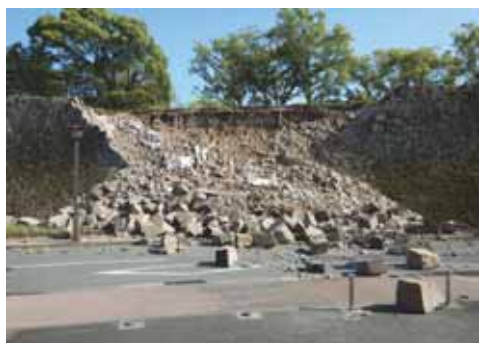
写真 8.1-1 百間石垣の崩壊
