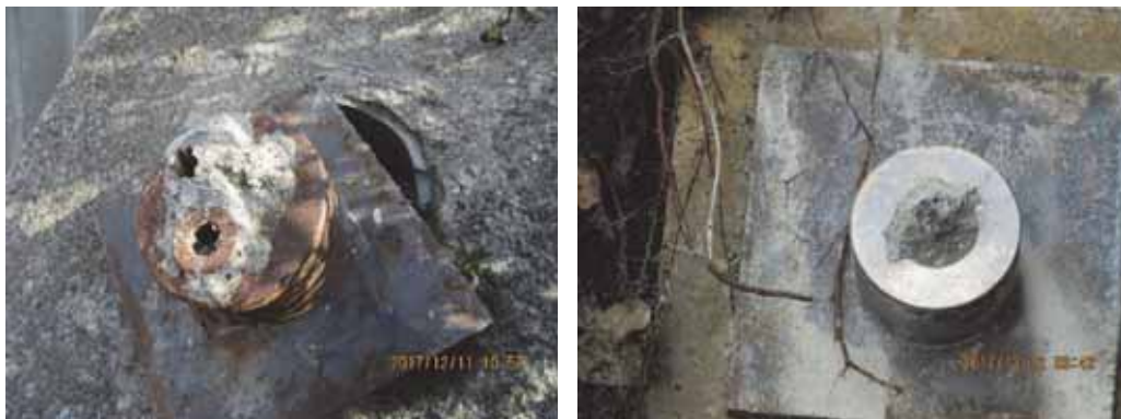
写真 4.4-1 調査地アンカー頭部状況
