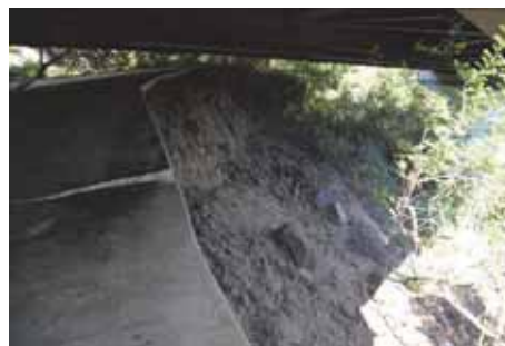
写真 5.2-2 A2 橋台周辺の地滑り 3)
