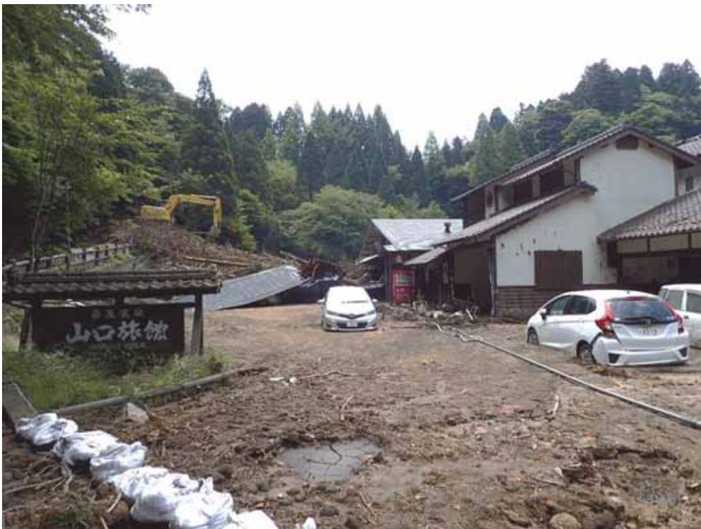
写真 2.6-7 山口旅館敷地に流入した泥流
