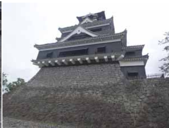
(b) 南面石垣 ( Z1 断面付近)
