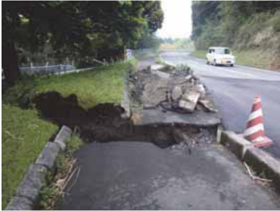
災害直後の状況（歩道に右横ずれ）
