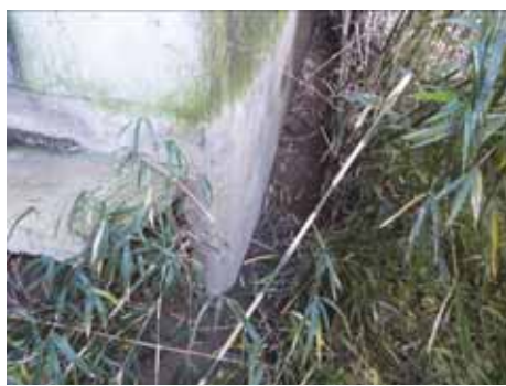
写真 5.2-3 A1 橋台北側の地盤変位 3)
