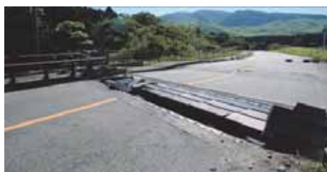
写真 5.2-7 A2 橋台側ジョイントの損傷
