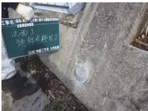
写真 4.3-6 破断したと考えられるアンカー施工部はモルタルで閉塞してある。既設の法枠工に明瞭な変状はない。
