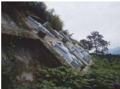
写真 4.3-12 既設法枠内への増しアンカー施工状況 増しアンカー施工後に変状が発生した形跡は見られず、安定した状態と判断される。
