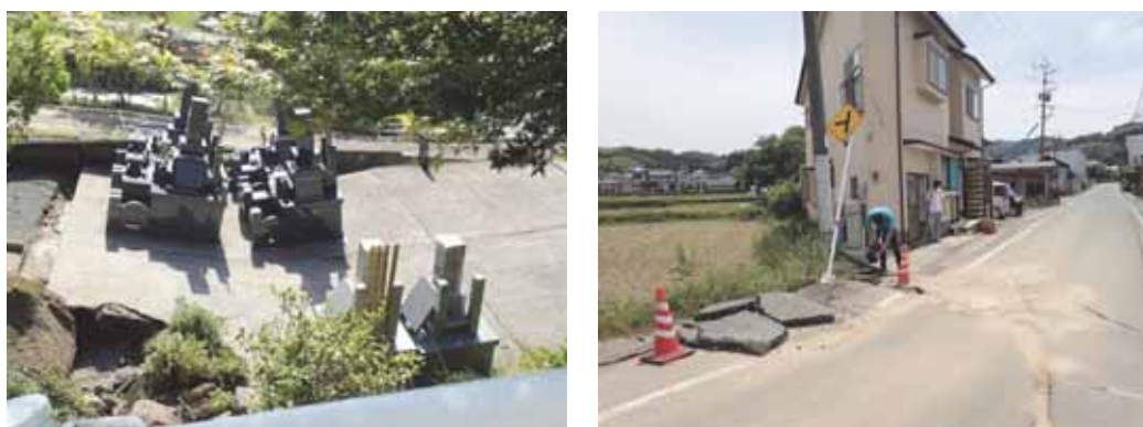
図 1.4-1 2016 年熊本地震本震による地表地震断層ごく近傍の様子 左：墓石の傾動（益城町杉堂），右：地表断層脇の家屋（益城町福原）
