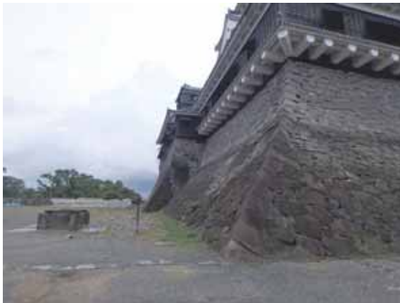
(a)南西面の石垣 ( Z2 断面付近)
