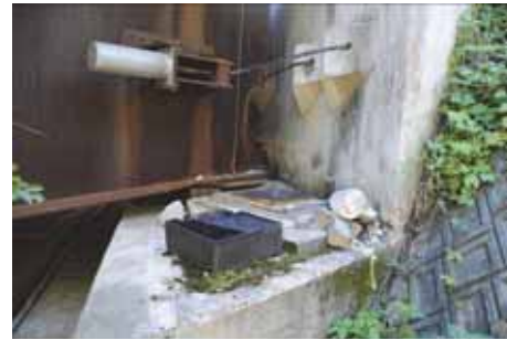
写真 5.2-10 A2 橋台の落橋防止ケーブル
