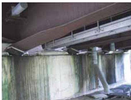
写真 5.2-4 A1 橋台の支承
