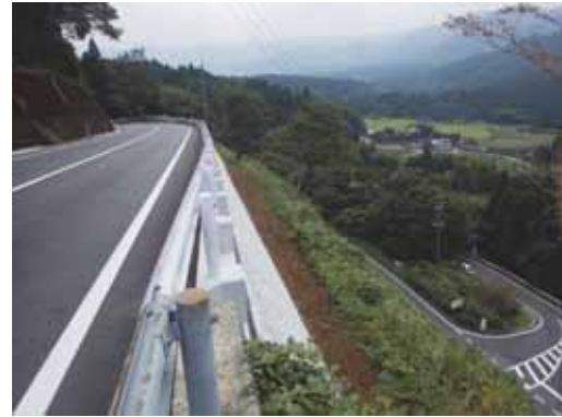
写真 4.3-10 対策工後は、路面や擁壁に新たな変状は見られず、アンカーによる効果が発揮されていると判断する。
