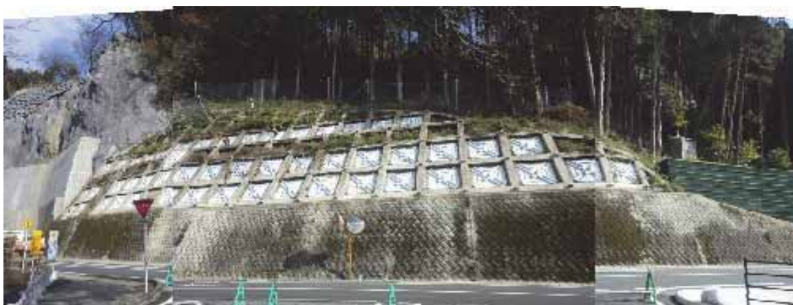
写真 4.3-1 法面1全景。ブロック積擁壁(H=4.5m,1:0.5)の上部斜面に既設対策工として「法枠工+アンカー工」が施工されている。枠内のアンカーは、既設アンカー破損に伴って増しアンカー工を施工したものである。
