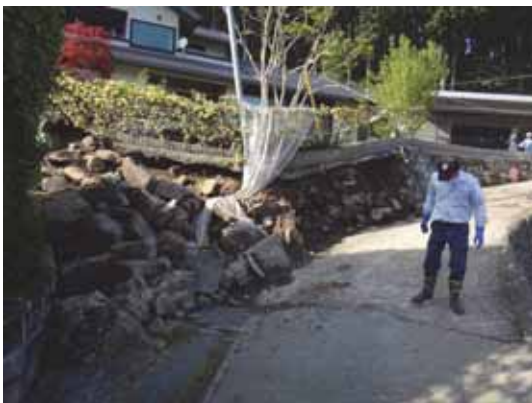
災害直後の法面崩壊の状況
