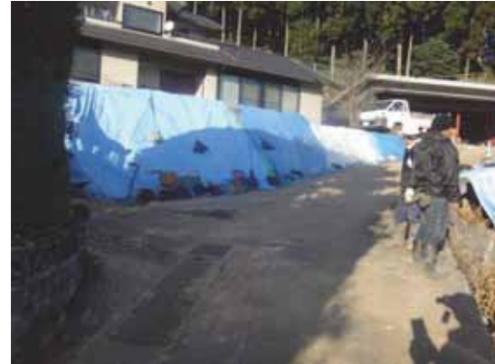
復旧工事中の状況
