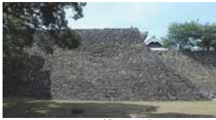
(a)測線 B4(変状なし)
