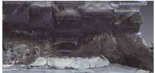
(b) 石垣崩壊部正面図
