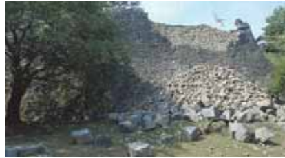
(c)測線 D3(崩落)
