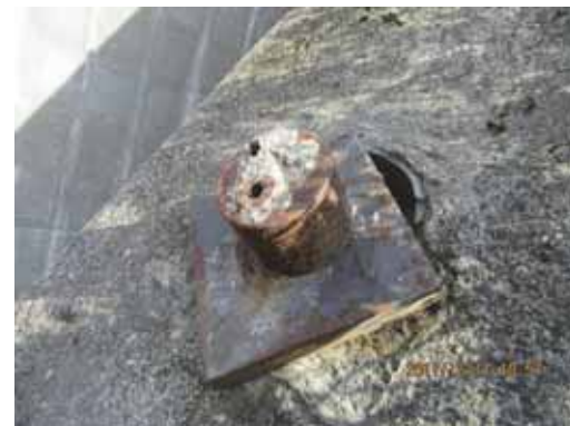
写真 4.3-5 より線の余長部分が見られない。プレートが回転しているため、緊張力はほとんどなく、かろうじて引っかかっている状況である。
