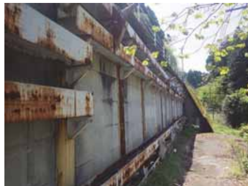
写真 4.3-13 アンカー付き山留め杭擁壁
