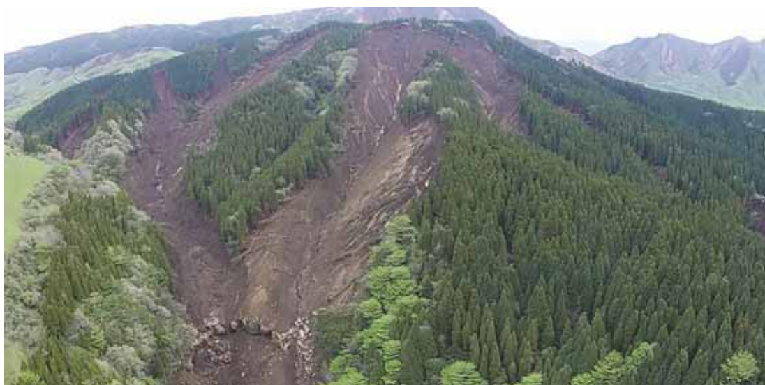
写真 2.5-1 山王谷川上流崩壊地状況（2016/4/26 撮影）
