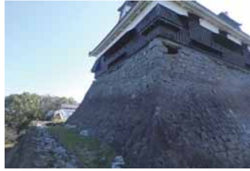
(b) 北西側の石垣崩壊
