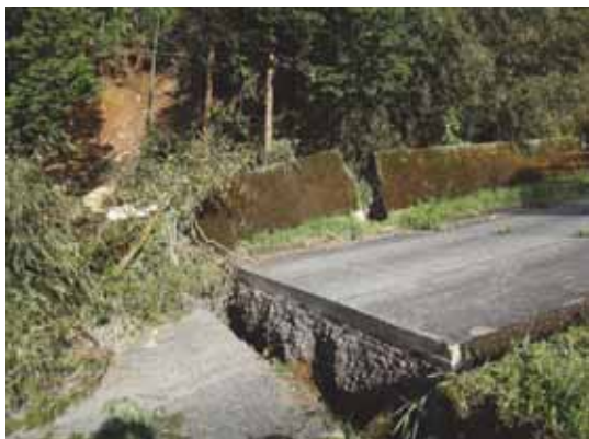
災害直後の状況（崩壊，道路段差）
