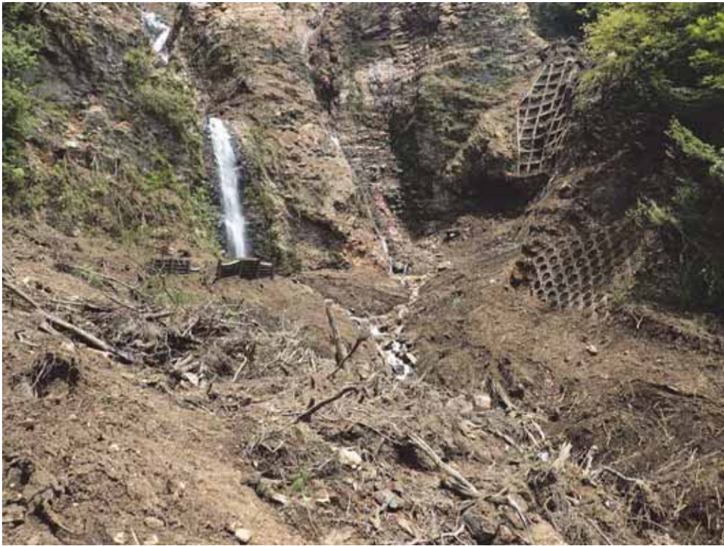
写真 2.6-6 H28. 6/3 時点の金龍の滝～垂玉川の状況
