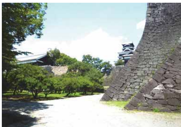
写真 8.1-20 二様の石垣の状況
