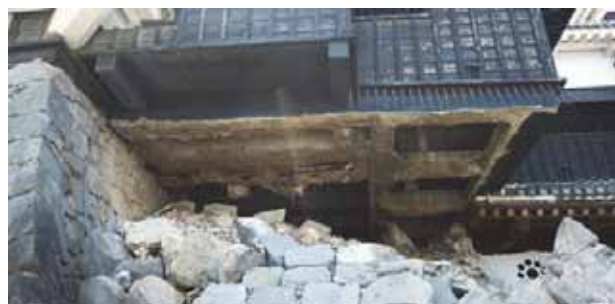
写真 8.1-22 天守の基礎部分の RC 梁
