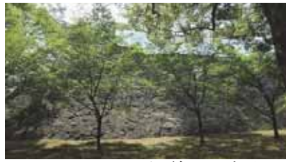
(b)測線 B3(変状あり)
