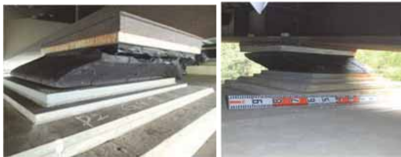
写真 5.2-11 P2 橋脚のゴム支承の損傷状況 4)
