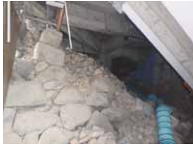
(c) 建物杭の露出
