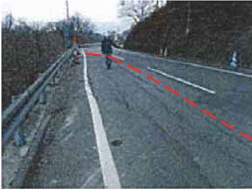
写真 4.3-9 地震発生直後には路面にクラックや沈下が見られる。
