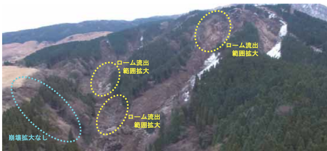
写真 2.5-3 山王谷川上流崩壊地状況（2017/12/9 撮影）
