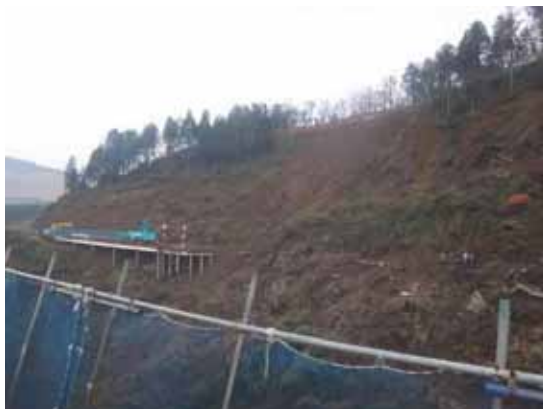
工事中の状況（地すべり対策）
