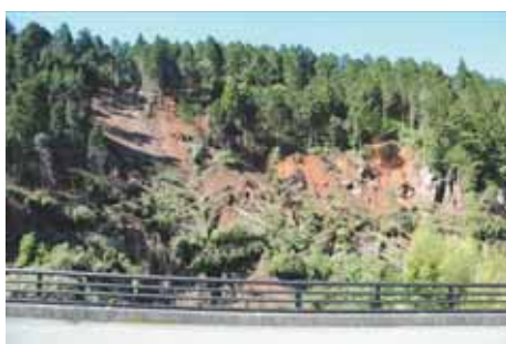
写真 5.2-1 本橋の南側における斜面崩壊
