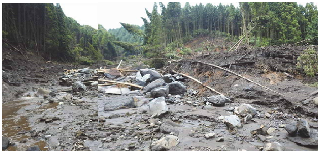
写真 2.5-7 三王谷川砂防堰堤上流の土砂堆積状況（2016/6/21 撮影） 13)
