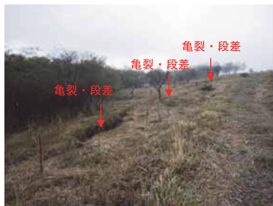
図 2.8-12 亀裂及び段差等々の状況
