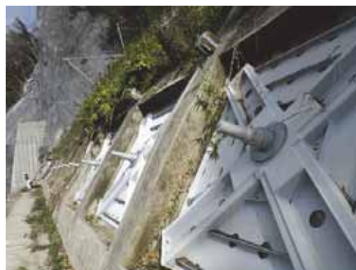
写真 4.3-7 多数の既設アンカーが破損しているため、法枠(500 枠)内に鋼製受圧板+アンカー工が施工されている。
