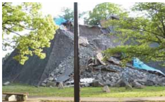
写真 8.1-24 北面の崩壊断面
