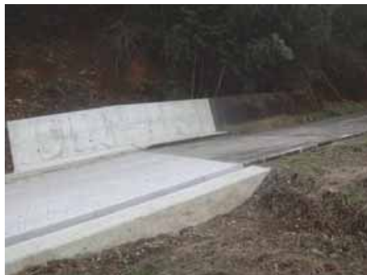
復旧工事の状況
