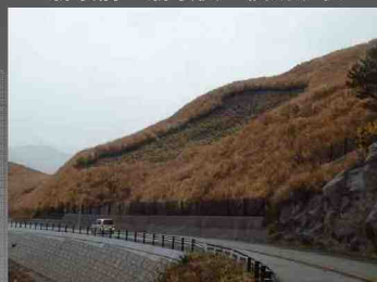
対象地(崩壊斜面)の状況 崩壊規模: 幅約25m, 長さ約50m, 深さ約1m (崩壊前の斜面勾配約34°)
