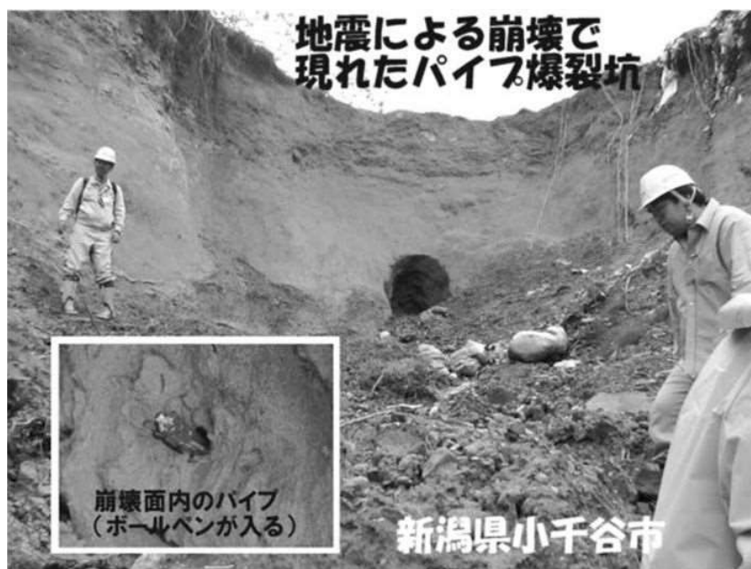
図 3.6 2004 年新潟県中越地震で巨大水圧により発生した孔
