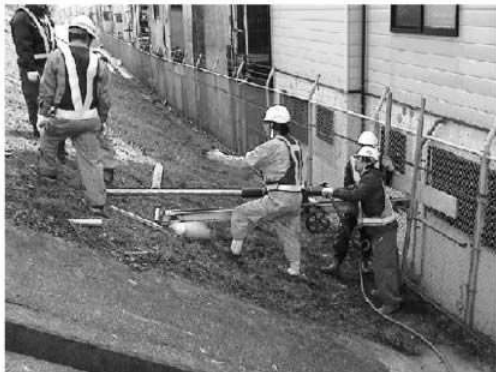
図 4.2 排水パイプによる対策
