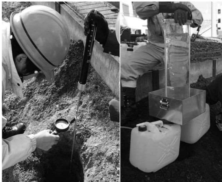
図 3.1 土層強度検査棒試験(左)と浅層型原位置透水試験
