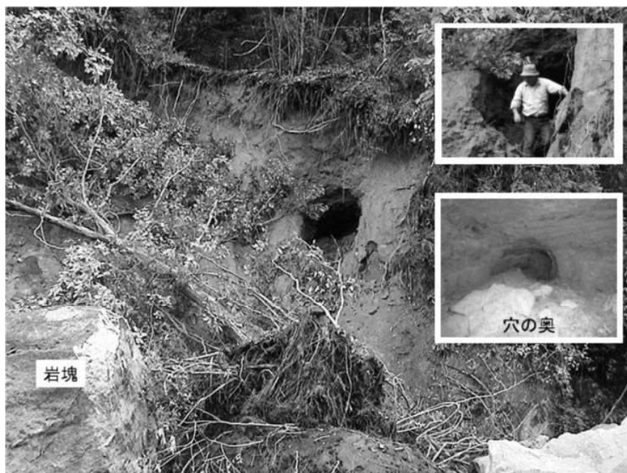
図 3.5 2003 年九州南部豪雨で巨大水圧により発生した孔
