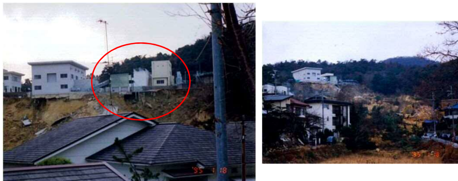
基礎杭が見える！→盛土部で、基礎杭よりも斜面下方側が滑落
