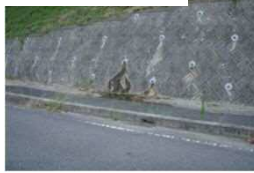
ブロック積み擁壁
