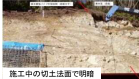
施工中の切土法面で明暗
