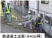
鉄道盛土法面 (S40以降)
