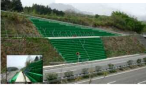
高速道路切土法面
