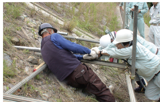
図3 パイプドレーン工施工状況
