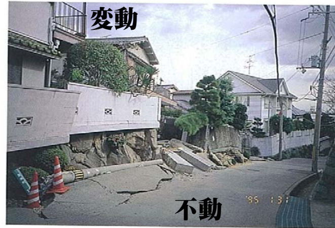
口絵-10 西宮市豊楽町における谷埋め盛土の変形 (盛土右岸) 手前の道路が切盛境界で、盛土は住宅を載せたまま、左下から右上に向かって移動した。変形によって膨張した盛土側 (移動土塊) が、道路に対して隆起している。
