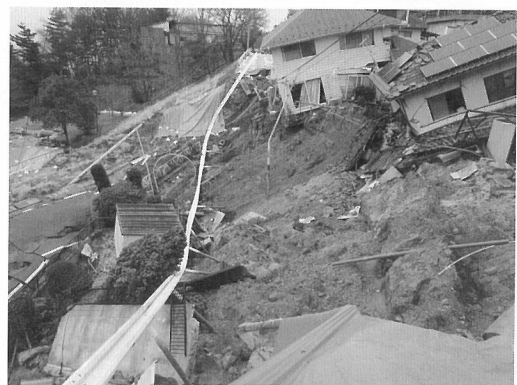
写真-5 福島市あさひ台の崩壊状況
