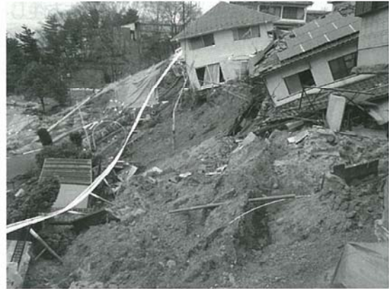
写真1 東日本大震災時の盛土地すべり
