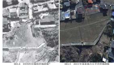
図3.4 1978年宮城総沖地震後 図3.5 2011年東北地方太平洋沖地震後
