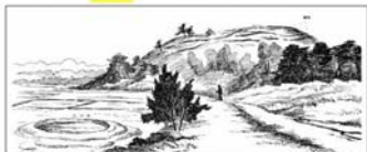
庄内地震による飯森山北麓の地割れとその後の噴砂 小暮文次郎（1896）震災予防調査
