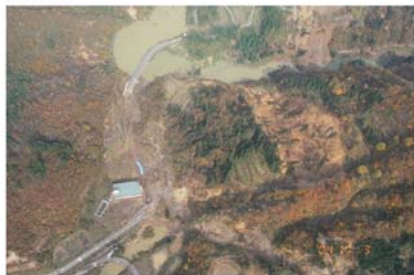
東竹沢で約100年を争う川上流部から望む、手前崩壊、移動土塊主要部、末端部の河堤開き状況を明確に読み取ることが出来る。
