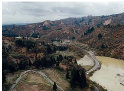
東竹沢で約100年を争う川上流部から望む、手前の斜面における国道29号線及びに赤田に生じた亀裂や崩壊は、地すべり性の斜面実状を反映したものと推察される。
