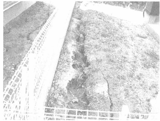
写真-7 盛土末端部の噴砂跡 (恵和町)
