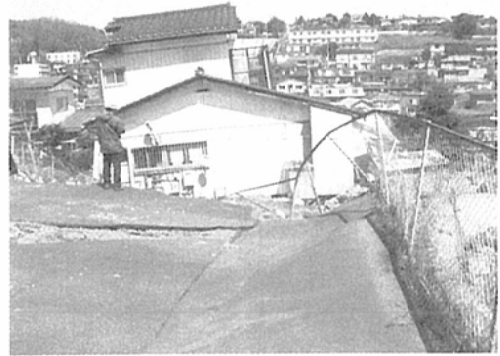
写真-3 小規模な腹付け盛土の崩壊 (青山2丁目)
