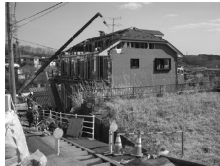
写真7 大きなアパートが傾き、解体中
