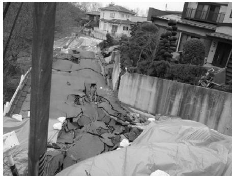
写真9 南側ユニットの崩壊
