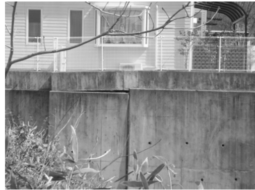
写真6 擁壁部の沈下程度の変状のみ
