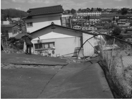
写真3 小規模な腹付け盛土の崩壊
