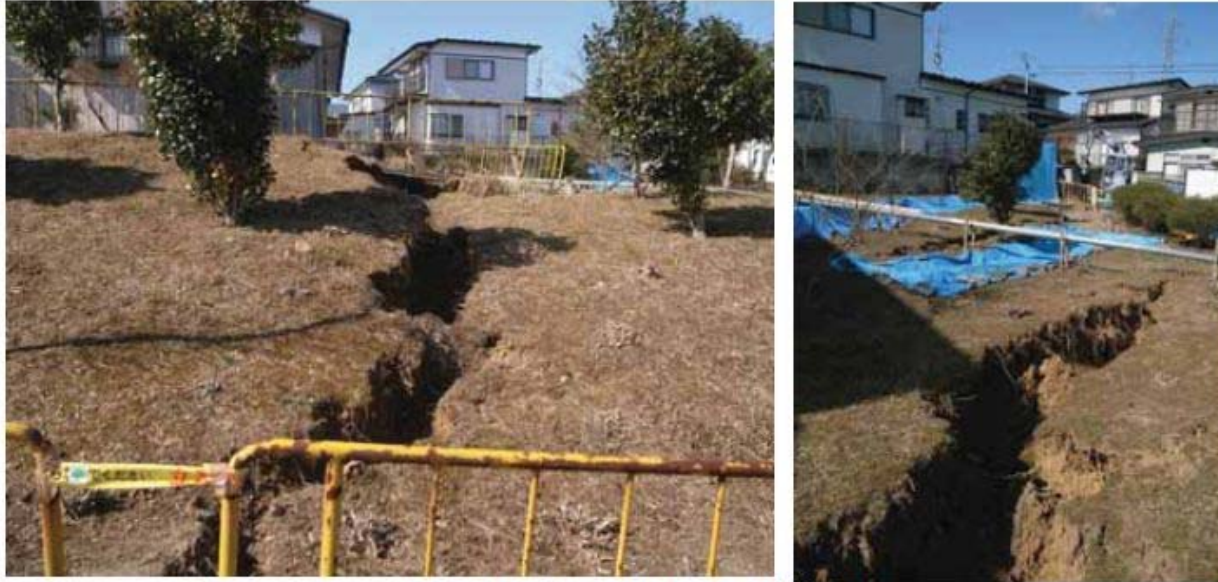
図3.8 IIブロック地すべり頭部亀裂 (1978年宮城県沖地震でも、ほぼ同様の位置に亀裂が発生：聞き取り調査による)
