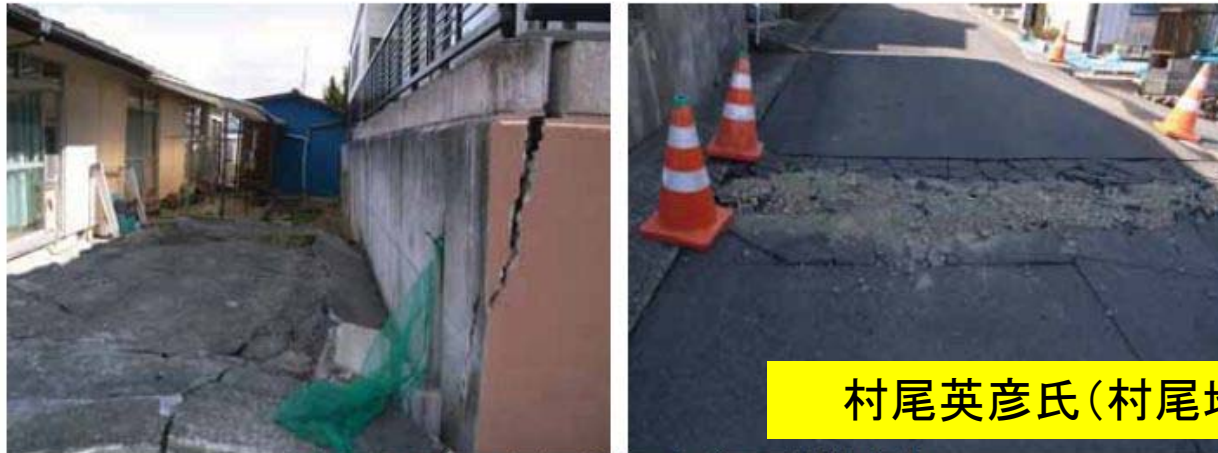
図3.9 IIブロック内の地すべりブロック側方亀裂
