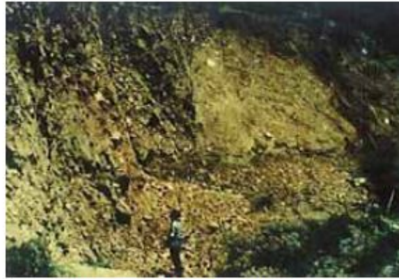
地すべり頭部の滑落
