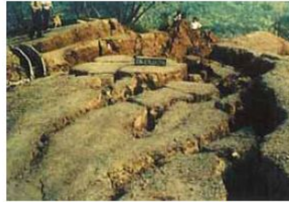
畑地の亀裂・陥没被害状況
