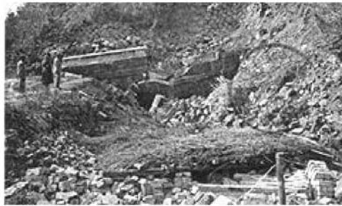
亀の瀬地すべり土塊内にあった国鉄関西本線のトンネル坑口が崩壊（昭和7年）
