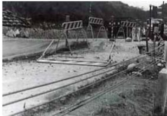
地すべり末端部に位置する国道25号の隆起による被害状況
