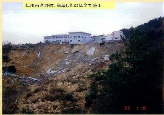
仁川百合野町: 崩壊したのは全て盛土
