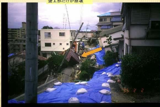
盛土部だけが崩壊
