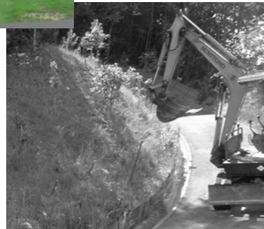
鉄筋挿入工（押し込み方式）
