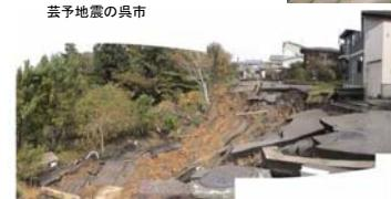
図表1.1-② 新潟県長岡市東町の盛土造成地の滑動崩落現象
