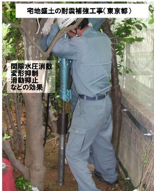
過剰間隙水圧消散工
