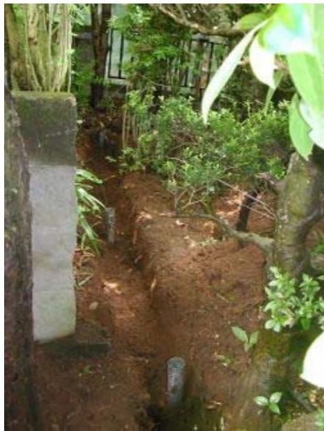
間隙水圧消散工の頭部連結を行う
