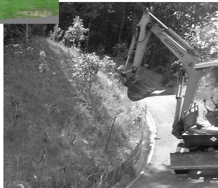
鉄筋挿入工（押し込み方式）
