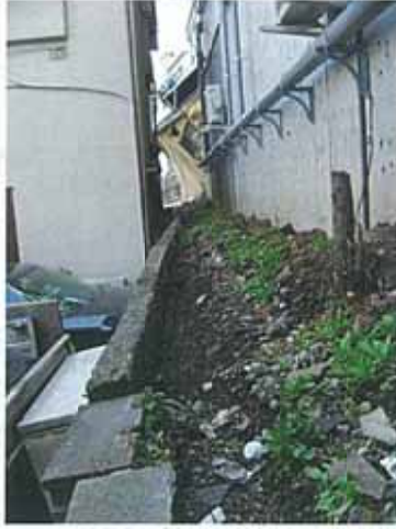
老朽化した斜面保護工と建築
