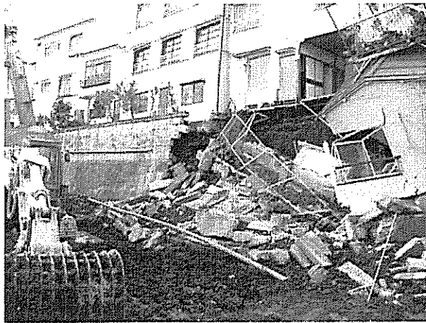
写真 2 西品川の斜面崩壊
