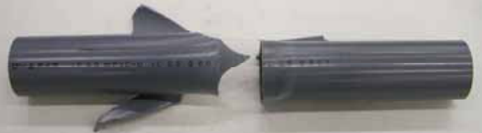
V P 50 差し込み継手破損状況
