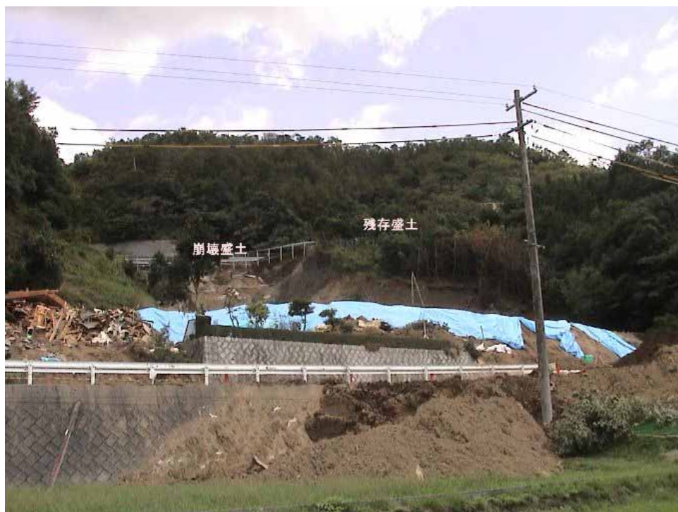
大規模盛土の北側が崩壊した
