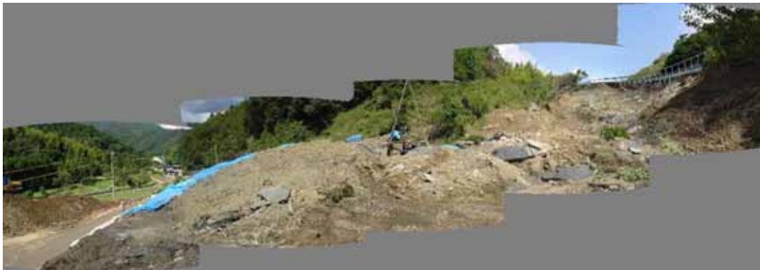
崩壊部～堆積部全景
