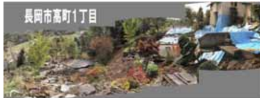
宅地の被災例:長岡市高町
