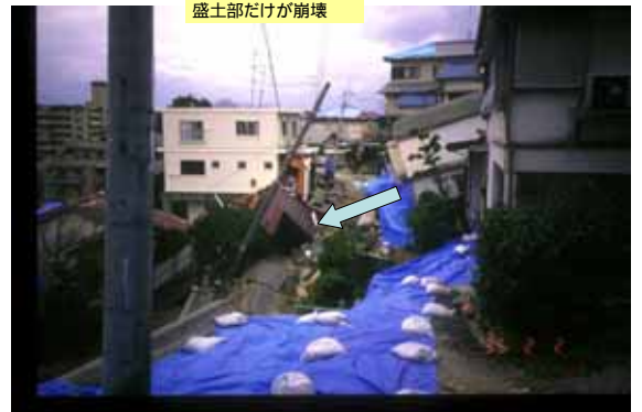
盛土部だけが崩壊
