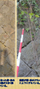
隙間の目地部分にクラックがあり、水の浸入がみられる。油断がある場合は、角部を修理する。
