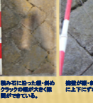
隙間の目地部分にクラックがあり、水の浸入がみられる。油断がある場合は、角部を修理する。
