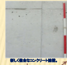
新しく健全なコンクリート擁壁。
