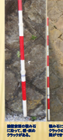
隙間の目地部分にクラックがあり、水の浸入がみられる。油断がある場合は、角部を修理する。
